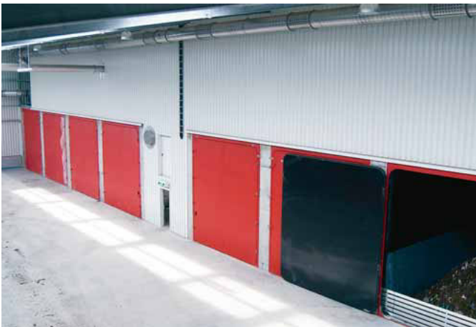
Sogenannter Tunnelfermenter (Boxenfermenter, Batchverfahren) von Eggersmann für die Trockenfermentation.
